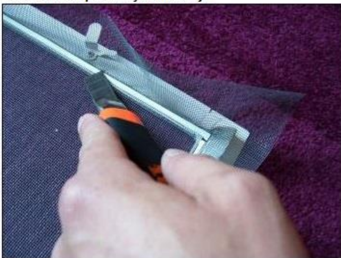
10 - zařiznutí přesahující síťoviny
