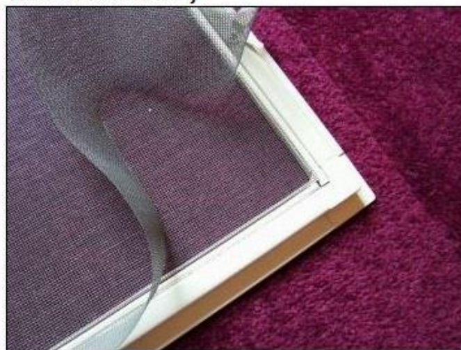
11 - odstarnění síťoviny
